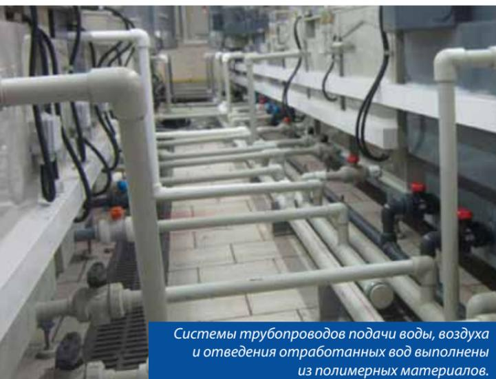
Системы трубопроводов подачи воды, воздуха и отведения отработанных вод выполнены из полимерных материалов.
