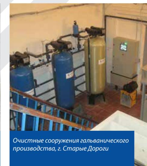
Очистные сооружения гальванического производства, г. Старые Дороги
