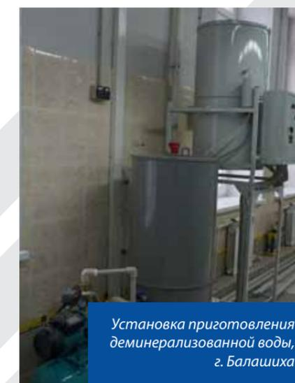
Установка приготовления деминерализованной воды, г. Балашиха
